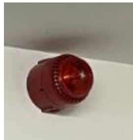
Sirène avec flash lumineux
