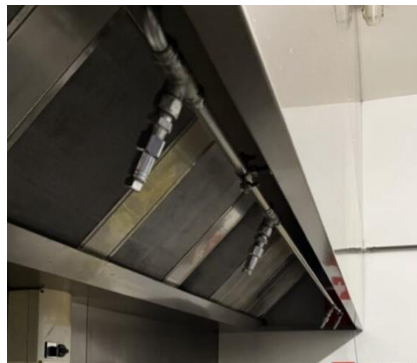
Têtes de pulvérisation au-dessus du poêle
