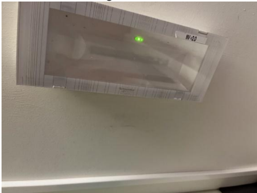
Autonome noodverlichtingsarmaturen (ontsteken bij uitvallen elektriciteit)
