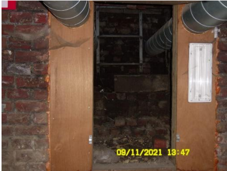
Vluchtweg met ladder (kelder -2)
